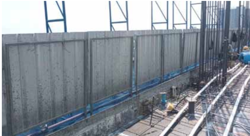
ติดตั้งราวกันตกบริเวณริมอาคาร และติดตั้งแผงกันตกช่องลิฟท์
