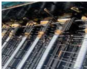
หัว Former แบบยางสำหรับ block out หัว Anchorage แทนแบบโฟม
