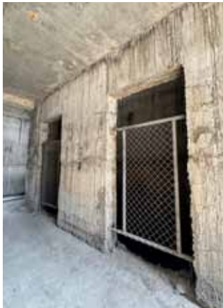
ติดตั้งราวกันตกบริเวณริมอาคาร และติดตั้งแผงกันตกช่องลิฟท์
