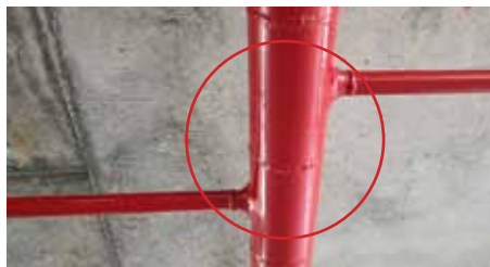
รูปแบบเดิม ต่อท่อดับเพลิงโดยใช้ข้อต่อ
