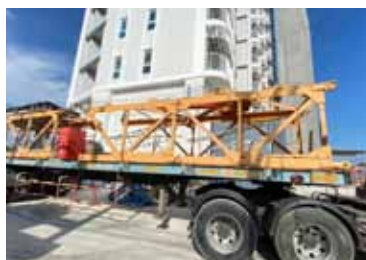
งานรื้อและขนย้าย Tower Crane
