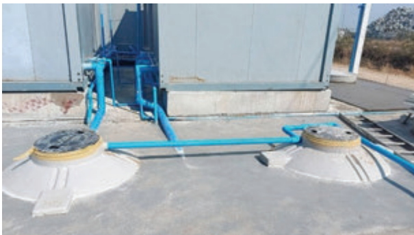
ภาพ : การติดตั้งถังบำบัดน้ำเสียสำเร็จรูปหรือระบบบำบัดน้ำเสียแบบบ่อคอนกรีต
