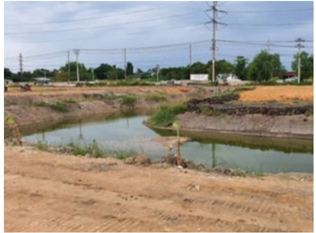
ภาพ : วางระบายน้ำและบ่อพักดักตะกอน
