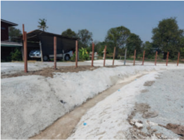
ภาพ : วางระบายน้ำและบ่อพักดักตะกอน
