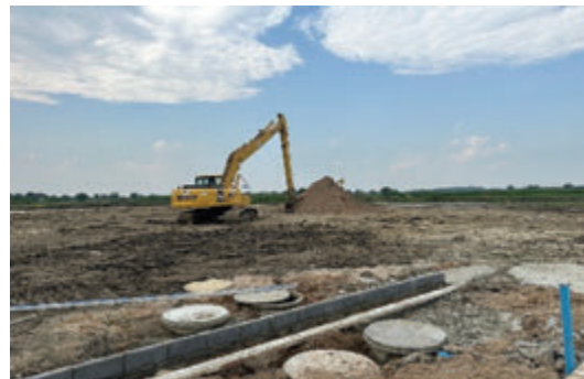
ภาพ : การติดตั้งถังบำบัดน้ำเสียสำเร็จรูปหรือระบบบำบัดน้ำเสียแบบบ่อคอนกรีต
