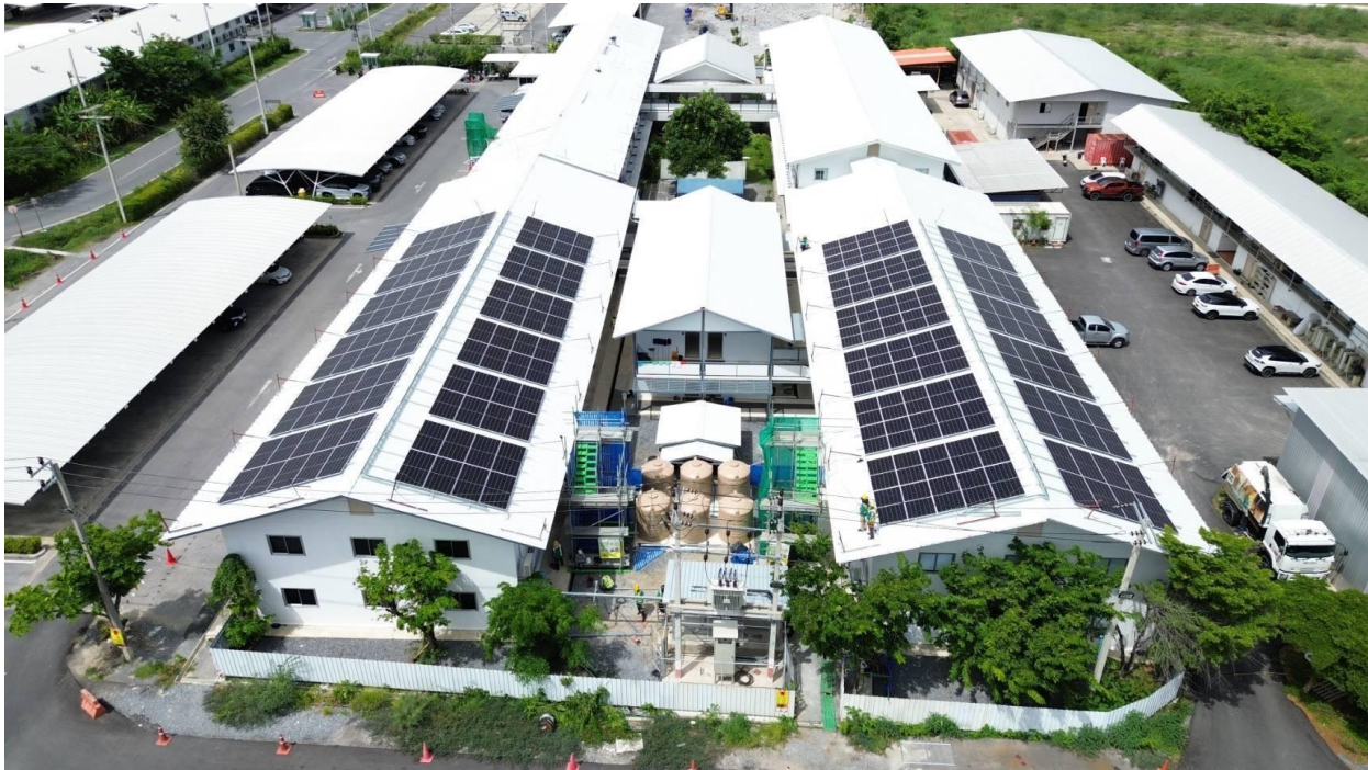
การติดตั้งแผงโซลาร์เซลล์บนอาคารสำนักงานโครงการฯ
