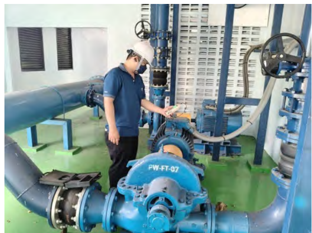
ตรวจวัดค่าความร้อนของมอเตอร์ปั๊ม
