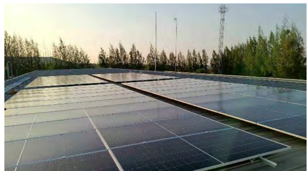
ติดตั้งระบบผลิตไฟฟ้าจากแสงอาทิตย์บนหลังคา (Solar Rooftop) อาคารคัดแยกขยะ ขนาด 52 กิโลวัตต์พีค (kWp)
