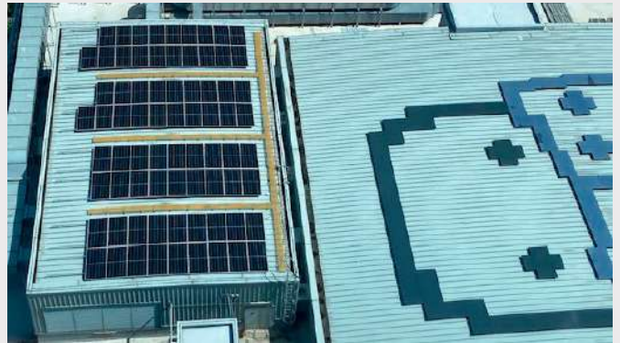
การติดตั้ง Solar Roof ที่โครงการสามย่านมิตรทาวน์ ด้วยกำลังการผลิต 40 KW
