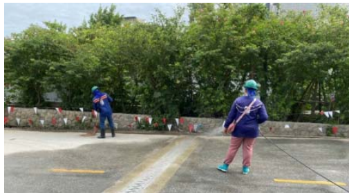
การดูแลเรื่องการป้องกันฝุ่นละอองฟุ้งกระจายในพื้นที่ก่อสร้างโดยการพรมน้ำ และล้างทำความสะอาด
