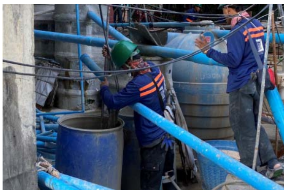
ทำบ่อดักตะกอนของเสีย เพื่อดักเศษตะกอนก่อนออกนอกโครงการ
