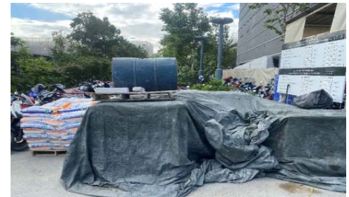
การปิดคลุมวัสดุในพื้นที่ก่อสร้างเพื่อป้องกันฝุ่นละออง และความชื้น ที่ อาจจะทำให้เกิดผลกระทบสร้างความเสียหายให้กับวัสดุก่อสร้างได้
