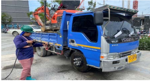
จัดให้มีจุดล้างล้อรถบริเวณทางออกโครงการ โดยรถทุกคัน ก่อนออกจากพื้นที่ โครงการต้องล้างล้อรถเพื่อไม่ให้มีดินโคลนล้อรถไปร่วงหล่นบนถนน
