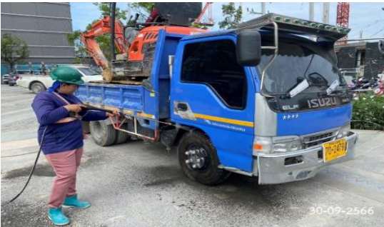
จัดให้มีจุดล้างล้อรถบริเวณทางออกโครงการ โดยรถทุกคัน ก่อนออกจากพื้นที่โครงการต้องล้างล้อรถเพื่อไม่ให้มีดินติดล้อรถไปรบกวนถนน
