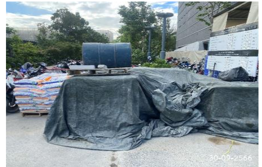
การปิดคลุมวัสดุในพื้นที่ก่อสร้างเพื่อป้องกันฝุ่นละออง และความชื้น ที่อาจจะทำให้เกิดผลกระทบสร้างความเสียหายให้กับวัสดุก่อสร้างได้
