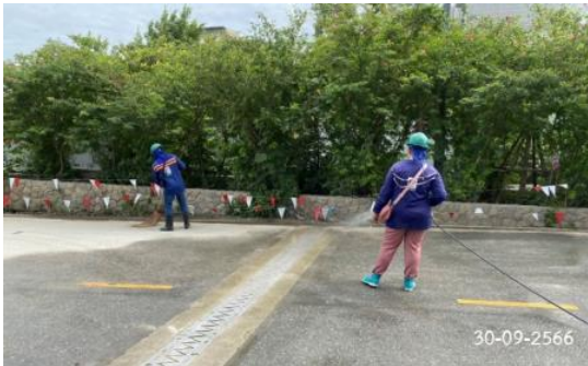
การดูแลเรื่องการป้องกันฝุ่นละอองฟุ้งกระจายในพื้นที่ก่อสร้างโดยการพรมน้ำและล้างทำความสะอาด
