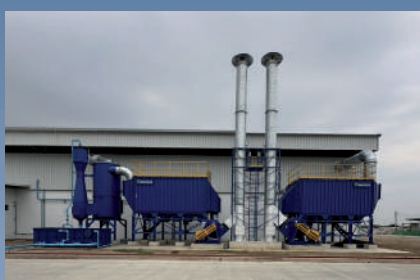
ติดตั้งระบบบำบัดกลิ่นสารละลาย ที่สายการผลิตกระเบื้องคอนกรีต CT-6, ครอบกระเบื้องคอนกรีต CF-4 ซึ่งเป็นสายการผลิตใหม่
