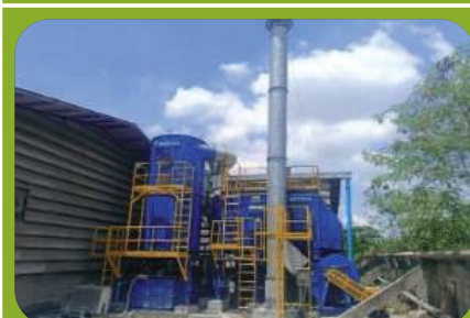
ปี 2568 ติดตั้งระบบบำบัดกลิ่นสารละลายที่สายการผลิต กระเบื้องคอนกรีต CF-3
