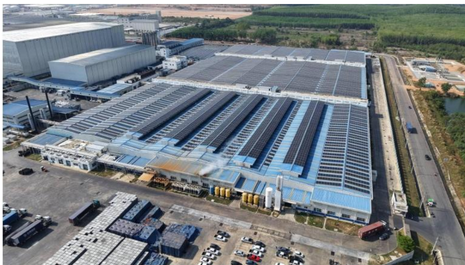
การติดตั้งระบบไฟฟ้าพลังงานแสงอาทิตย์กำลังผลิต 9.988 MW
