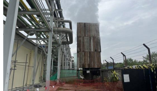
ภาพการติดตั้งอุปกรณ์ลดเสียงภายในโครงการก่อสร้าง
