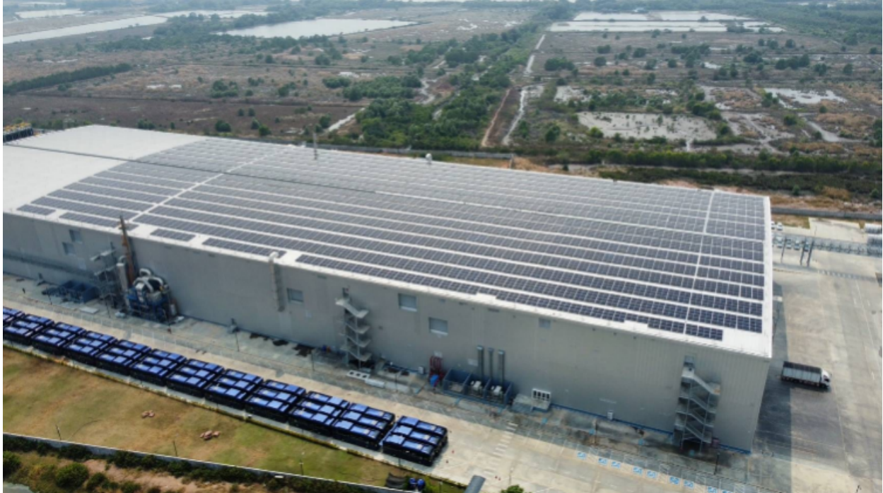
รูปภาพโครงการแผงโซลาร์เซลล์ติดตั้งบนหลังคา Solar rooftop
