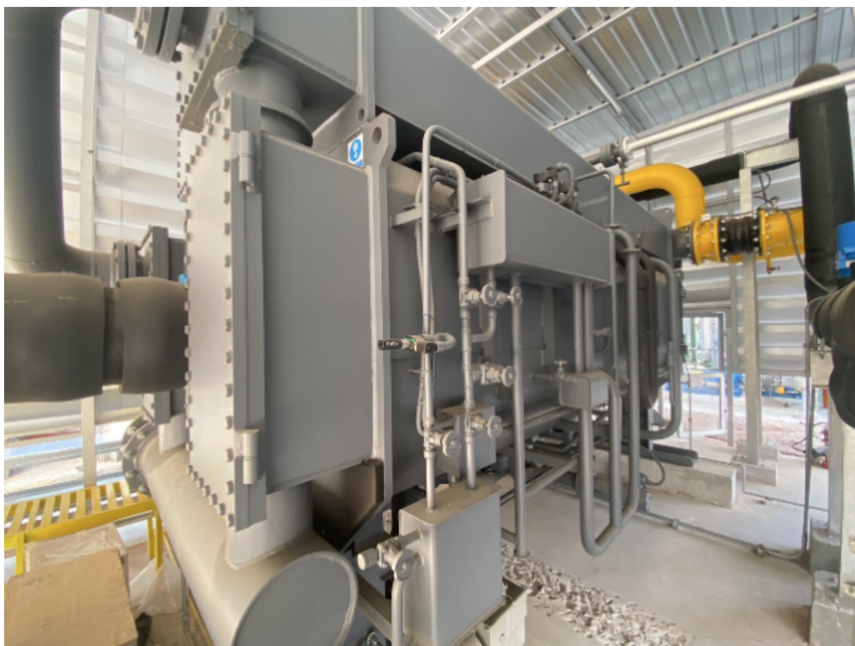
รูปภาพโครงการติดตั้งระบบทำความเย็นแบบดูดซึม ชนิด LiBr
