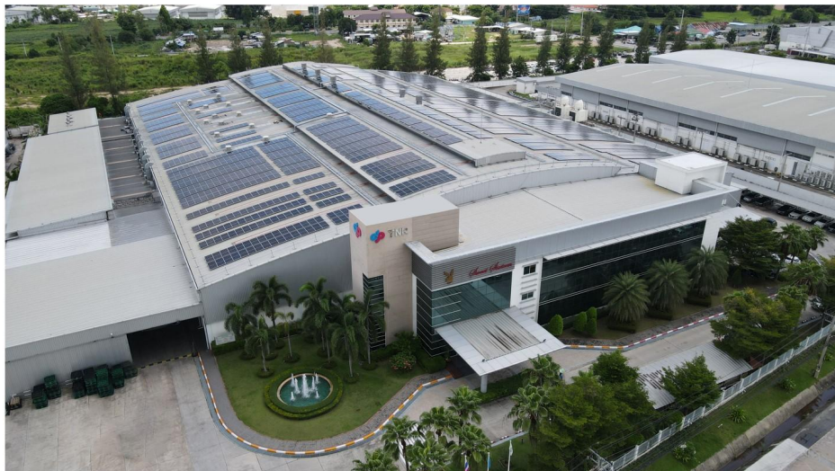
โครงการติดตั้งระบบผลิตไฟฟ้าจากพลังงานแสงอาทิตย์ (Solar Rooftop) ขนาด 999.68 kW
