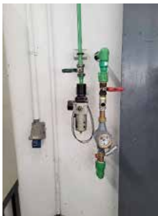
รูปติดตั้งมิเตอร์น้ำบริเวณ Workshop เพื่อวัดปริมาณน้ำในกิจกรรม Workshop ออกจากน้ำใช้ในสำนักงาน
