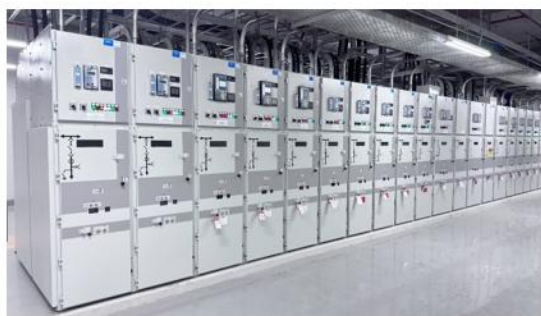
ตู้ไฟฟ้าระดับแรงดันปานกลาง (MV Switchgear)
