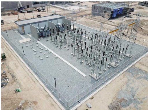
ภาพแสดง 115 kV. Substation (สถานีไฟฟ้าย่อย) พร้อมระบบ Network IEC61850 เชื่อมโยงกับระบบการรายงานผลและควบคุมผ่านเส้นใยนำแสง
