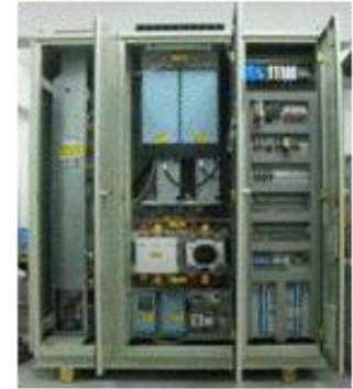
ภาพแสดงระบบ Regenerative Inverter ควบคุมความเร็วโดยระบบ PLC และการสื่อสารกับระบบรายงานผลจากคอมพิวเตอร์
