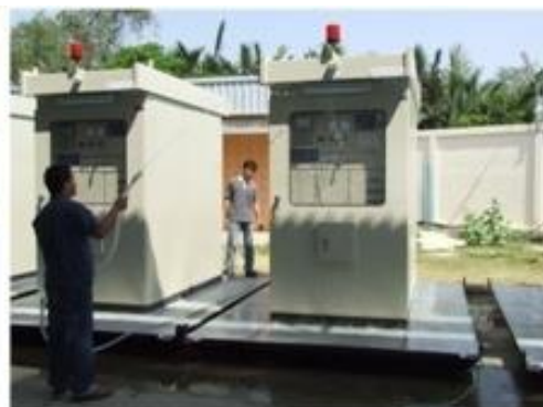
ภาพแสดง Motor Starter Panel ขนาดไฟแรงดัน 6,600 Volt ที่สามารถเคลื่อนย้ายได้
