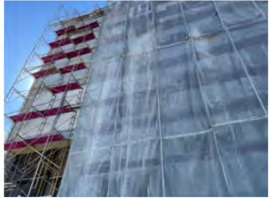
ภาพนั่งร้านสำหรับการก่อสร้างซึ่งสามารถนำกลับมาใช้ซ้ำได้ การสั่งซื้อให้พอดีกับจำนวนที่ต้องใช้
