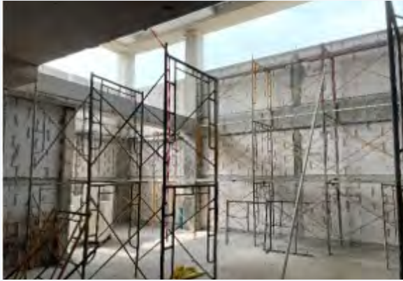
ภาพนั่งร้านสำหรับการก่อสร้างซึ่งสามารถนำกลับมาใช้ซ้ำได้ การสั่งซื้อให้พอดีกับจำนวนที่ต้องใช้
