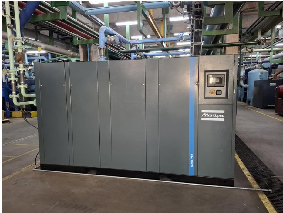
โครงการประหยัดพลังงานระบบอัดอากาศ (Air Compressor 6 Bar) ของบริษัท บีจีซี กลาส โซลูชั่น จำกัด
