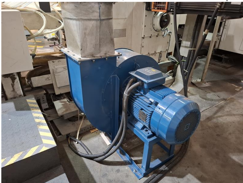
โครงการเปลี่ยนมอเตอร์ประสิทธิภาพสูง (IE4) สำหรับระบบพัดลมดูดอากาศ (Suction Fan) ของบริษัท บางกอกบรรจุมณฑา จำกัด
