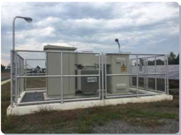
หม้อแปลงไฟฟ้า (Transformer)
