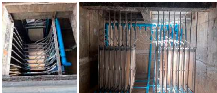
ชุด Membrane ที่ติดตั้งในระบบบำบัดน้ำเสีย MBR
