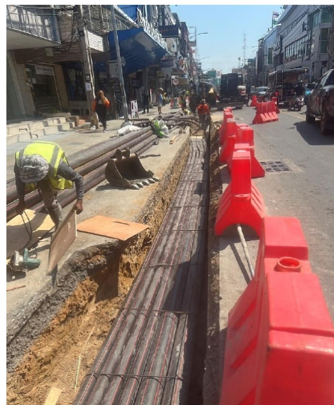
งานปรับปรุงระบบจำหน่ายเป็นเคเบิลใต้ดิน สฟ.พัทยาใต้ 2
