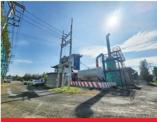
ภาพระบบล้างฝุ่นแบบเปียก (Wet Scrubber) ณ โรงผลิตแอสฟัลต์คอกอนกรีต
