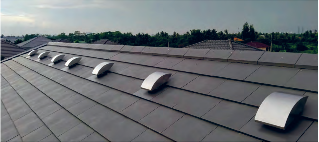
ระบบถ่ายเทอากาศในบ้าน (SCG Active Airflow™ System)
