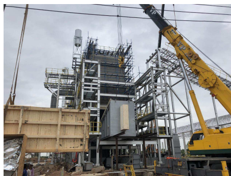
งานก่อสร้างฐานรากเครื่องจักรและติดตั้งเครื่องจักร Boiler
