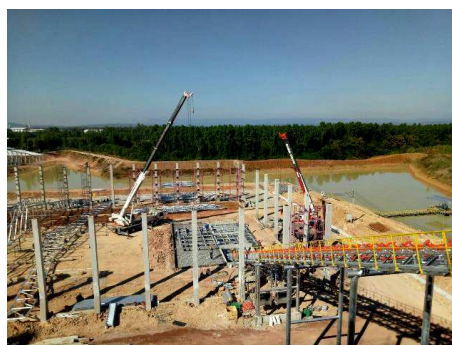
งานก่อสร้างและติดตั้งเครื่องจักร ระบบลำเลียงเชื้อเพลิง (Fuel handling system)
