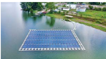
Floating Solar ในอ่างเก็บน้ำดิบ นิคมอุตสาหกรรมเกตเวย์ ซิตี้ ขนาด 117.35 kWp
