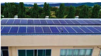
Solar Rooftop บนหลังคาอาคาร สำนักงานนิคมอุตสาหกรรม เกตเวย์ ซิตี้ ขนาด 11.70 kWh
