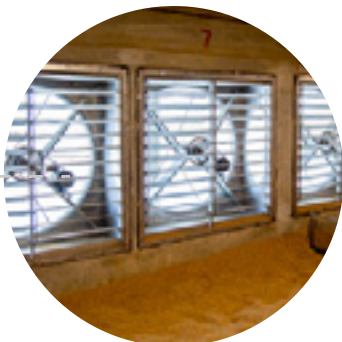
โรงเรือนระบบปิดปรับอากาศ (Evaporative Cooling System)
