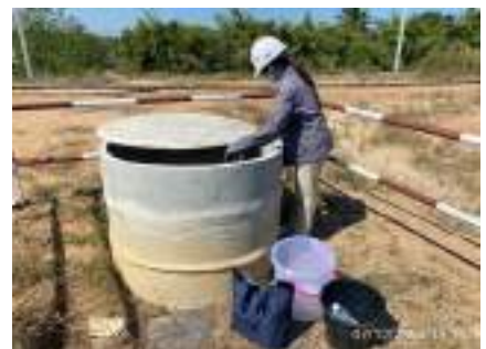
ภาพรางระบายน้ำชั่วคราว, ระบบบำบัดน้ำเสียสำเร็จรูปและการตรวจวัดคุณภาพน้ำทั้งในพื้นที่โครงการ
