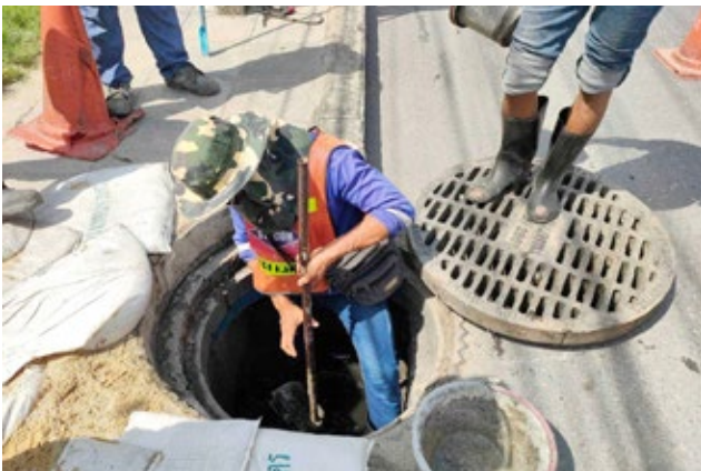
การลอกท่อน้ำทิ้งในช่วงฤดูฝน เพื่อลดการท่วมขังของปริมาณน้ำในชุมชนที่มีน้ำท่วมขัง
