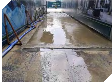
การล้างล้อรถที่เข้าโครงการเพื่อป้องกันเศษดินติดล้อรถออกสู่ถนน
