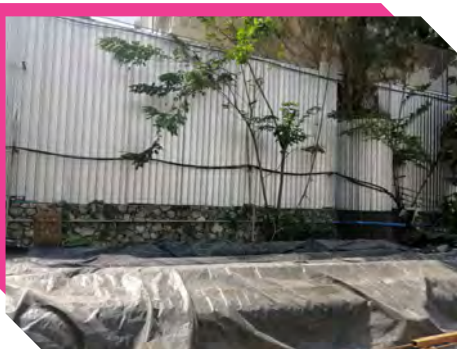
ปิดผ้าใบคลุมวัสดุก่อสร้าง เพื่อลดฝุ่นภายในโครงการ
