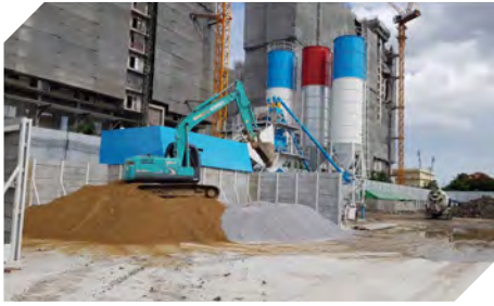
ตั้งโรงผลิตคอนกรีตชั่วคราวภายในโครงการ ช่วยลดมลพิษที่เกิดจากการขนส่ง
