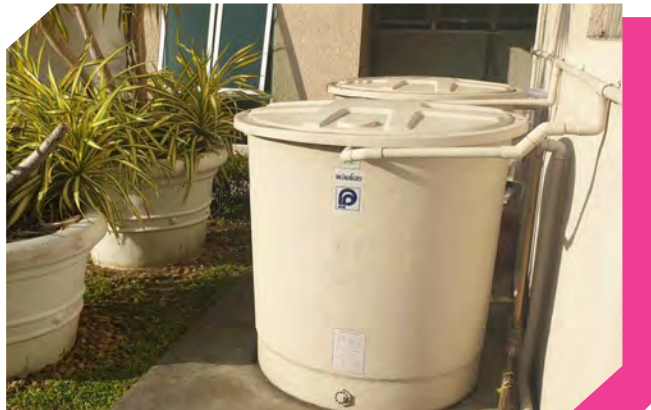
ใช้น้ำจากการกลั่นตัวจากระบบปรับอากาศหลัก (Chiller Plant) ภายในอาคารนำกลับไปใช้ในระบบปรับอากาศขนาดเล็ก (Cooling Tower)
