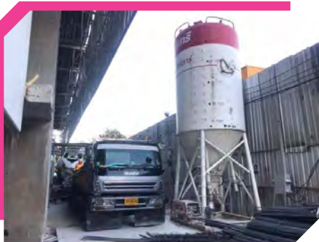
ใช้โซโลปูนฉาบและปูนปรับระดับพื้น ลดมลพิษที่เกิดจากการขนส่ง
