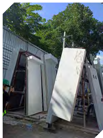
ผนัง Precast แกนผนังอิฐก่อเพื่อลดผลกระทบสิ่งแวดล้อม
