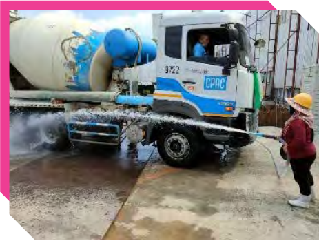
การล้างล้อรถที่เข้าโครงการเพื่อป้องกันเศษดินติดล้อรถออกสู่ถนน
