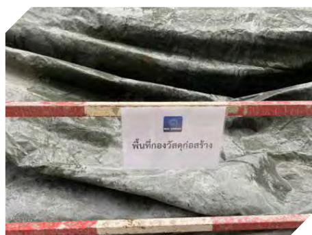
ปิดผ้าใบคลุมวัสดุก่อสร้าง เพื่อลดฝุ่นภายในโครงการ
