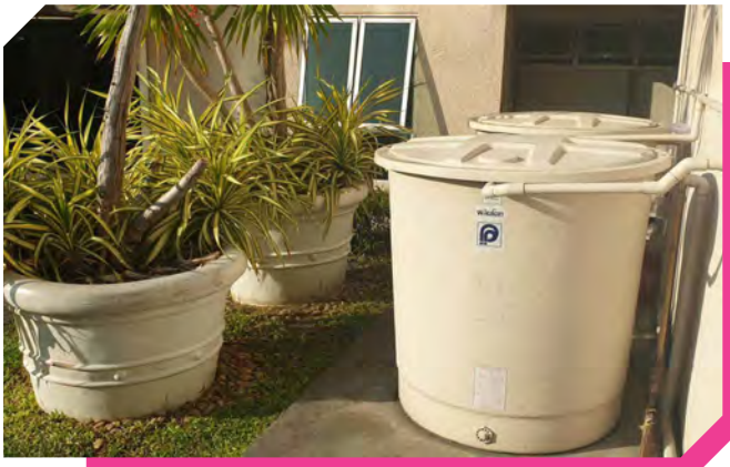
การนำน้ำจากระบบทำความเย็นกลับมารดน้ำต้นไม้
