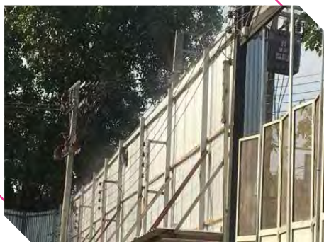
รั้วรอบโครงการสูง 6 เมตร และติดตั้งสเปรย์น้ำรั้วชั่วคราวรอบโครงการ เพื่อป้องกันเสียงและฝุ่น
