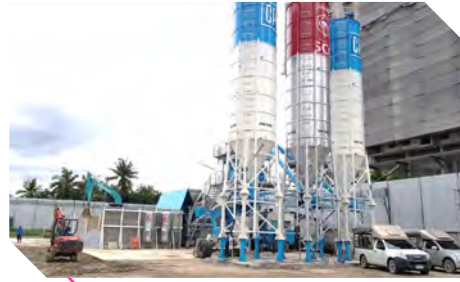
ตั้งโรงผลิตคอนกรีตชั่วคราวภายในโครงการ ช่วยลดมลพิษที่เกิดจากการขนส่ง
