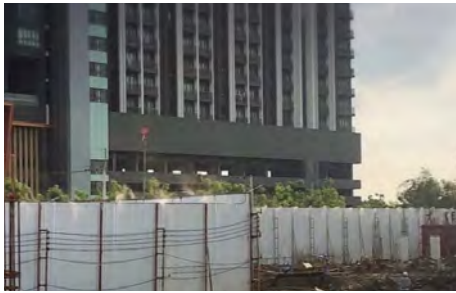
รั้วรอบโครงการสูง 6 เมตร และติดตั้งสเปรย์น้ำรั้วชั่วคราวรอบโครงการ เพื่อป้องกันเสียงและฝุ่น
