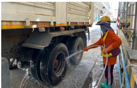
ล้างล้อรถที่เข้าโครงการ เพื่อป้องกันเศษดินติดล้อรถออกสู่ถนน
