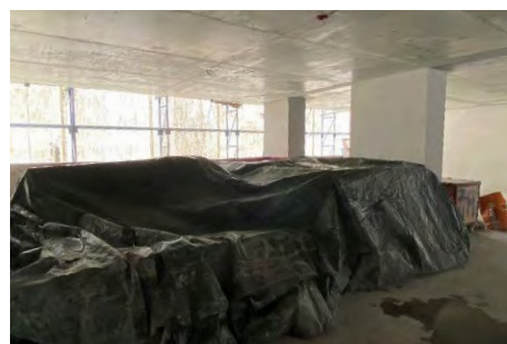
ปิดผ้าใบคลุมวัสดุก่อสร้าง เพื่อลดฝุ่นภายในโครงการ
