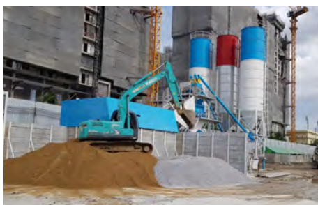
ตั้งโรงผลิตคอนกรีตชั่วคราวภายในโครงการ เพื่อช่วยลดมลพิษที่เกิดจากการขนส่ง
