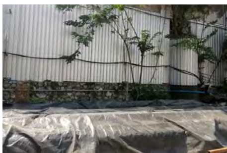
ปิดผ้าใบคลุมวัสดุก่อสร้าง เพื่อลดฝุ่นภายในโครงการ
