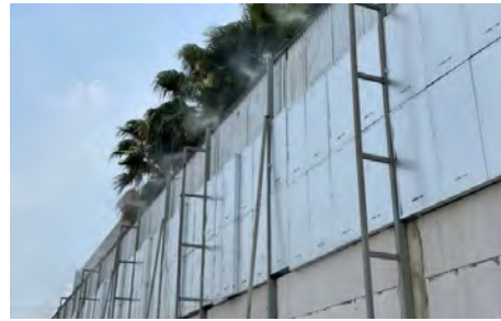
รั้วรอบโครงการสูง 6 เมตร และติดตั้งสเปรย์น้ำรั้วชั่วคราวรอบโครงการ เพื่อป้องกันเสียงและฝุ่น
