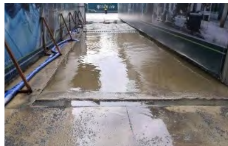
ล้างล้อรถที่เข้าโครงการ เพื่อป้องกันเศษดินติดล้อรถออกสู่ถนน
