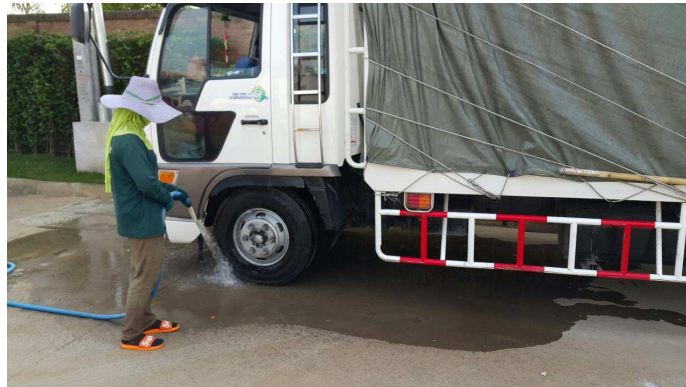
ทำความสะอาดล้อรถก่อนออกจากโครงการเพื่อควบคุมไม่ให้ฝุ่นละอองฟุ้งไปนอกพื้นที่ก่อสร้าง
