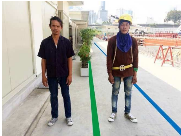
แบ่งเลนทางเดินในไซต์งานก่อสร้างเพื่อความปลอดภัย
