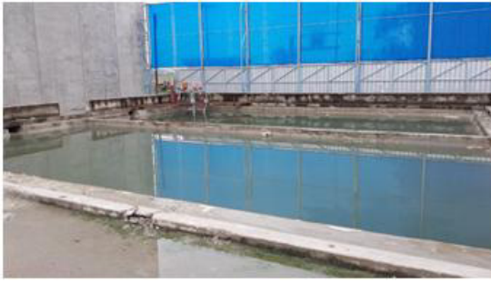
ภาพ : บ่อพักหรือรางดักตะกอน
