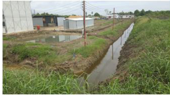
ภาพ : บ่อพักหรือรางดักตะกอน
