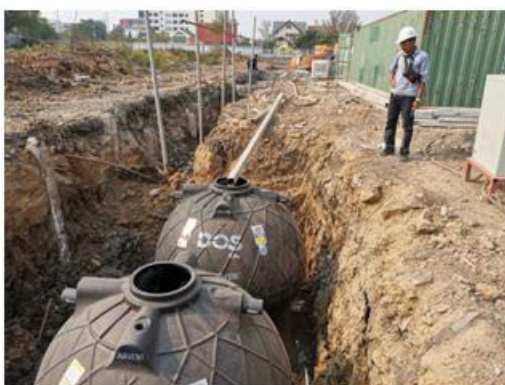
ภาพ : การติดตั้งถังบำบัดน้ำเสียสำเร็จรูปหรือระบบบำบัดน้ำเสียแบบบ่อคอนกรีต
