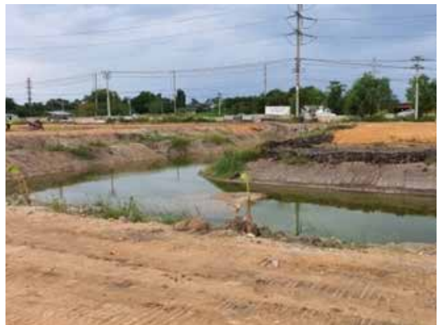
ภาพ : รางระบายน้ำและบ่อพักดักตะกอน
