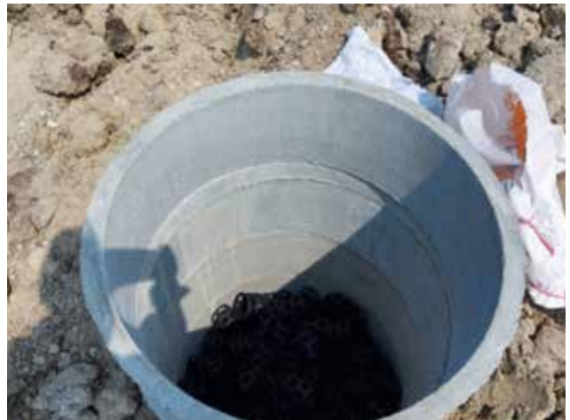
ภาพ : การติดตั้งถังบำบัดน้ำเสียสำเร็จรูปหรือระบบบำบัดน้ำเสียแบบบ่อคอนกรีต
