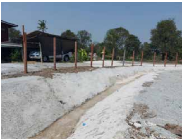
ภาพ : รางระบายน้ำและบ่อพักดักตะกอน
