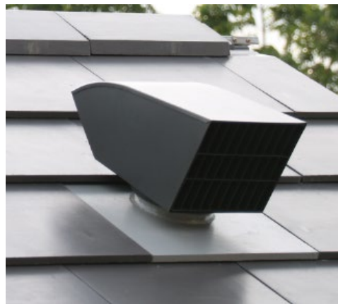
ภาพตัวอย่างระบบ Passive Ventilation ซึ่งระบายความร้อนใต้หลังคาด้วยลมธรรมชาติ โครงการ โนเบิล เกเบิล วัชรพล
