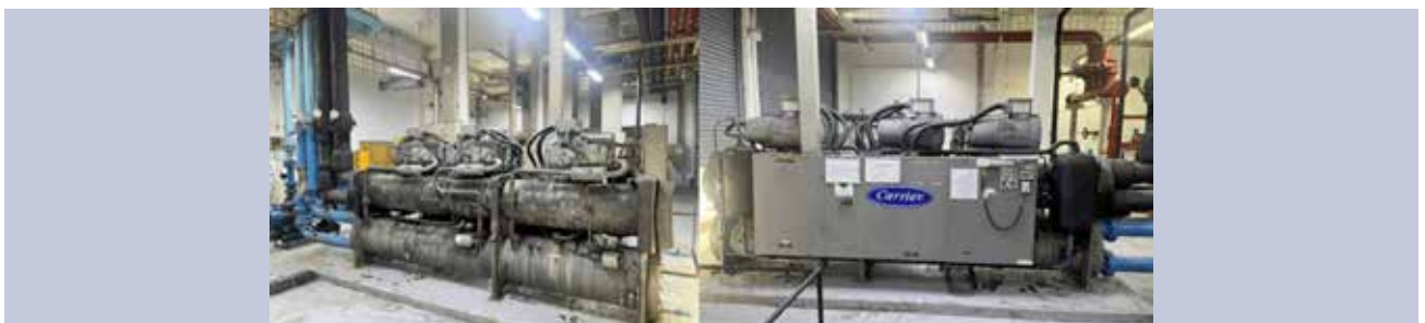
หมายเหตุ: รูปการเปลี่ยนมาใช้ระบบทำความเย็นชนิดระบายความร้อนด้วยอากาศประสิทธิภาพสูงที่โรงงานเพชรบุรี
