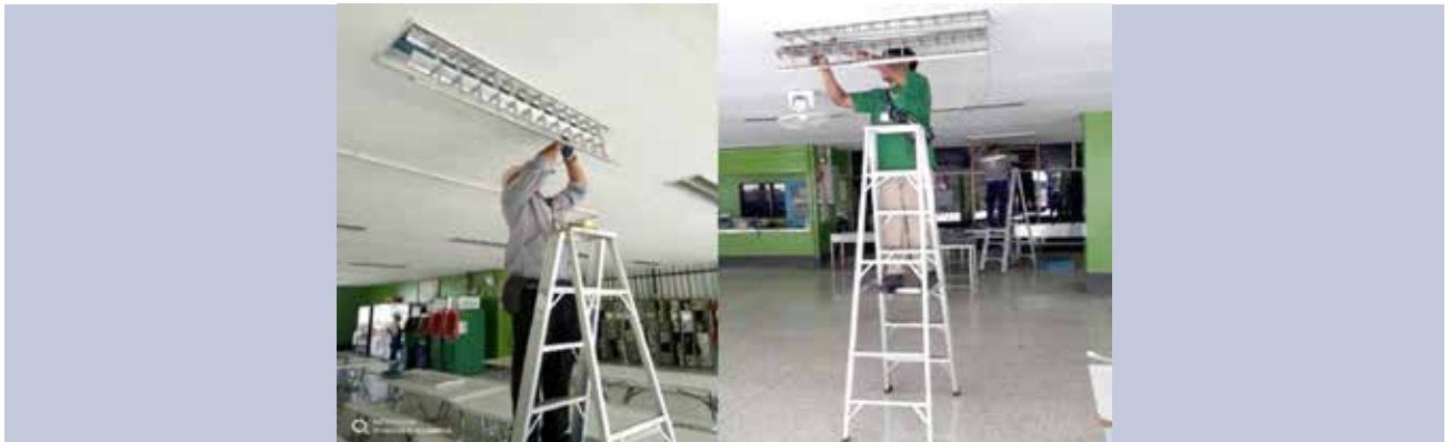
หมายเหตุ: รูปการเปลี่ยนหลอดไฟเป็นชนิด LED ที่โรงงานเพชรบุรี
