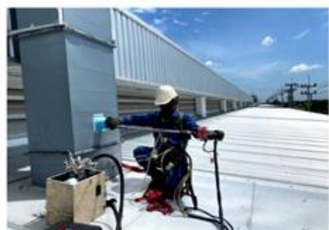
พื้นที่ตรวจวัด : ปล่องระบายอากาศ ฝั่งคลังสินค้า
