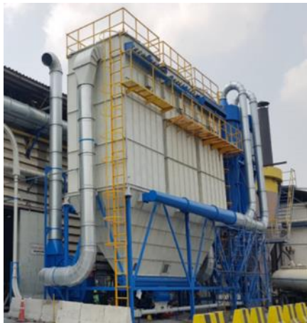
ดูดฝุ่นจากการแปรรูปในสายการผลิต และเป่าฝุ่นส่งผ่านระบบท่อไปเข้า SILO
