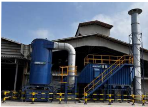
ติดตั้งระบบบำบัดกลิ่นสารละลาย ที่สายการผลิตกระเบื้องคอนกรีต
