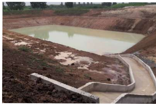
สร้างบ่อเก็บและพักน้ำที่สายการผลิต อิฐมวลเบา จ.สระบุรี
