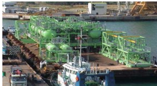
การติดตั้งเครื่องจักร อุปกรณ์ และโครงสร้างเหล็ก อุตสาหกรรมกลั่นน้ำมัน
