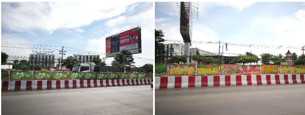
การลดผลกระทบด้านทัศนียภาพตามแนวพื้นที่ก่อสร้าง โดยการติดตั้งผ้าใบพิมพ์ลวดลายต้นไม้ และดอกไม้ตามธรรมชาติ
