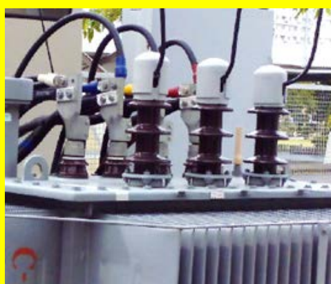
ครอบบูชิ่งหม้อแปลงไฟฟ้า
