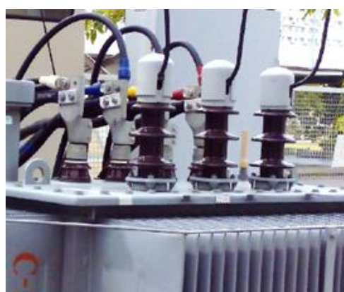
ครอบบูชชิงหม้อแปลงไฟฟ้า
