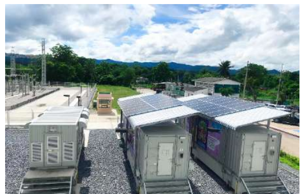
ภาพแสดงอุปกรณ์กักเก็บพลังงาน (Battery Energy Storage system) ขนาด 3MW/2.2 MWh โครงการพัฒนาระบบไฟฟ้าแบบโครงข่ายไฟฟ้าขนาดเล็กมาก (microgrid) ที่ อ.แม่สะเรียง จ.แม่ฮ่องสอน ของการไฟฟ้าส่วนภูมิภาค
