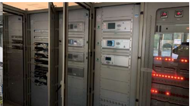
ภาพแสดงอุปกรณ์ควบคุมระบบไฟฟ้าอัจฉริยะ (Microgrid controller) โครงการพัฒนาระบบไฟฟ้าแบบโครงข่ายไฟฟ้าขนาดเล็กมาก (microgrid) อ.แม่สะเรียง จ.แม่ฮ่องสอน ของการไฟฟ้าส่วนภูมิภาค
