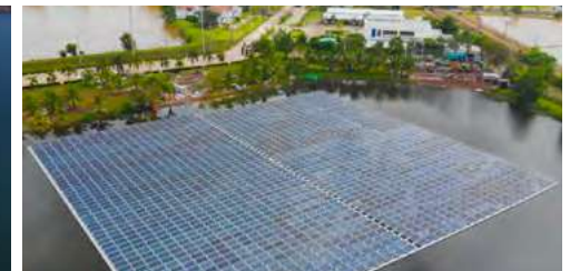
ภาพแสดงโครงการโรงไฟฟ้าพลังงานแสงอาทิตย์แบบติดตั้งบนน้ำ บริษัท ปราจีนบุรีกลาส อินดัสตรี จำกัด ขนาด 696.80 กิโลวัตต์
