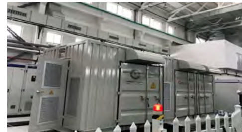
ภาพแสดงอุปกรณ์ระบบไฟฟ้าอัจฉริยะ (Microgrid Controller) โครงการพัฒนาระบบไฟฟ้าแบบโครงข่ายไฟฟ้าขนาดเล็กมาก (Microgrid) อ.แม่สะเรียง จ.แม่ฮ่องสอน ของการไฟฟ้าส่วนภูมิภาค
