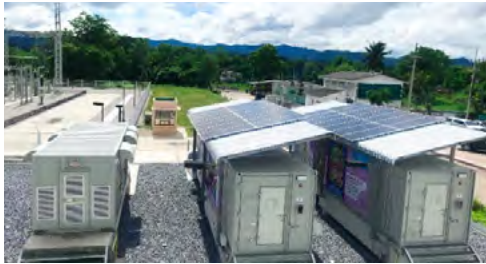
ภาพแสดงอุปกรณ์กักเก็บพลังงาน (Battery Energy Storage system) ขนาด 3 เมกะวัตต์/2.2 MWh โครงการพัฒนาระบบไฟฟ้าขนาดเล็กมาก (microgrid) ที่ จ.แม่ฮ่องสอน จ.แม่ฮ่องสอน ของกรมไฟฟ้าส่วนภูมิภาค
