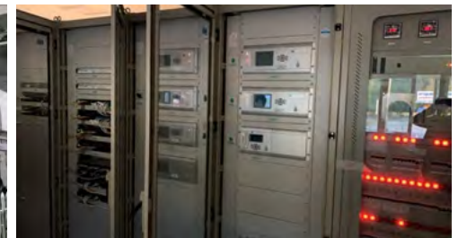
ภาพแสดงอุปกรณ์ระบบไฟฟ้าอัจฉริยะ (Microgrid Controller) โครงการพัฒนาระบบไฟฟ้าแบบโครงข่ายไฟฟ้าขนาดเล็กมาก (Microgrid) อ.แม่สะเรียง จ.แม่ฮ่องสอน ของการไฟฟ้าส่วนภูมิภาค
