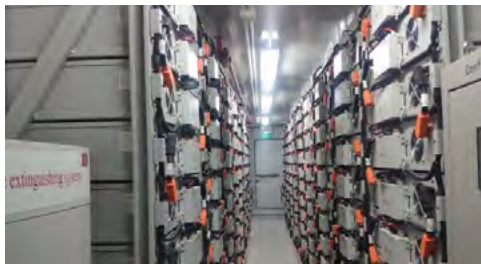
ภาพแสดงอุปกรณ์กักเก็บพลังงาน (Battery Energy Storage system) ขนาด 3 เมกะวัตต์/2.2 MWh โครงการพัฒนาระบบไฟฟ้าขนาดเล็กมาก (microgrid) ที่ จ.แม่ฮ่องสอน จ.แม่ฮ่องสอน ของกรมไฟฟ้าส่วนภูมิภาค
