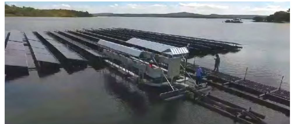
ภาพแสดงโครงการโรงไฟฟ้าพลังงานแสงอาทิตย์แบบติดตั้งบนน้ำ เขื่อนสิรินธร ขนาด 256 กิโลวัตต์
