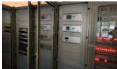
ภาพแสดงอุปกรณ์ควบคุมระบบไฟฟ้าอัจฉริยะ (Microgrid Controller) โครงการพัฒนาระบบไฟฟ้าแบบโครงข่ายไฟฟ้าขนาดเล็กมาก (Microgrid) อ.แม่สะเรียง จ.แม่ฮ่องสอน วงการไฟฟ้าส่วนภูมิภาค
