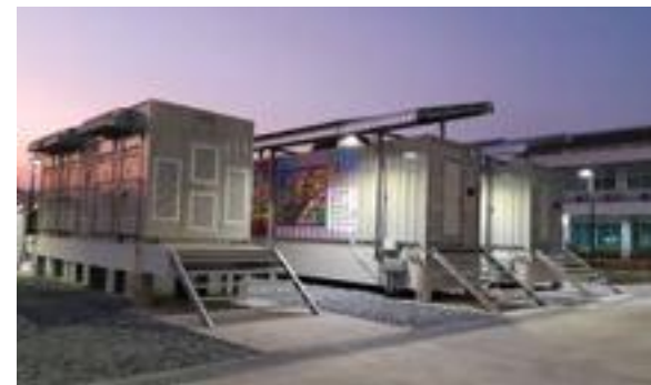
ภาพแสดงอุปกรณ์กักเก็บพลังงาน (Battery Energy Storage System) ขนาด 3 เมกะวัตต์/ 2.2 MWh โครงการพัฒนาระบบไฟฟ้า แบบโครงข่ายไฟฟ้าขนาดเล็กมาก (Microgrid) ที่ อ.แม่สะเรียง จ.แม่ฮ่องสอน วงการไฟฟ้าส่วนภูมิภาค
