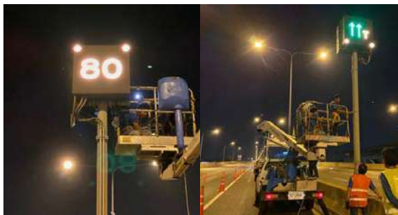
แจ้งการปิดช่องทาง และแนะนำความเร็วที่เหมาะสม ผ่านป้ายสัญญาณจราจร (Matrix Sign)
