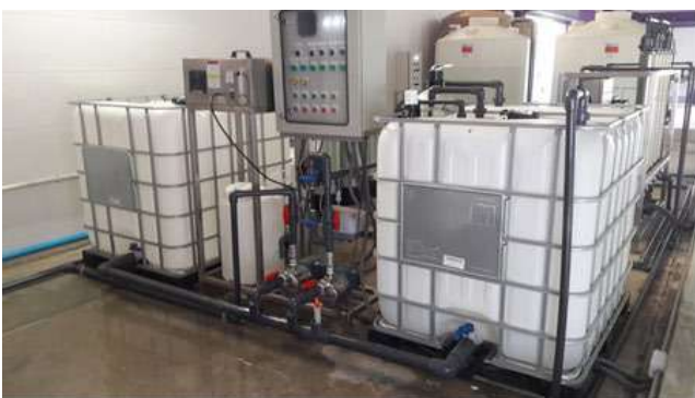
WASTEWATER TREATMENT SYSTEM & RO SYSTEM เป็น ระบบบำบัดน้ำเสียจากการกระบวนการผลิตเพื่อป้องกันไม่ให้น้ำเสีย จากกระบวนการผลิตถูกปล่อยออกจากโรงงานผลิต
