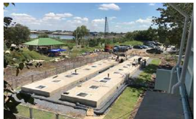
งานติดตั้งระบบบำบัดน้ำเสียที่มาจากโรงพยาบาล ก่อนปล่อยออกสู่แหล่งน้ำธรรมชาติ
