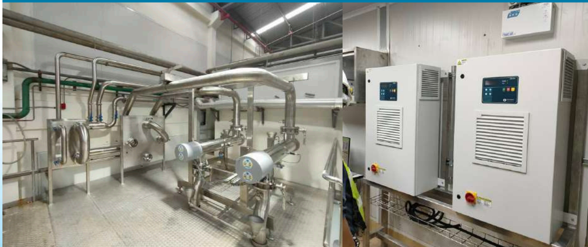
โครงการงานติดตั้ง UVLA 3200-8 จำนวน 2 set 150 m3hr. (บริษัท ไทยน้ำทิพย์ จำกัด โรงงานนครราชสีมา)
