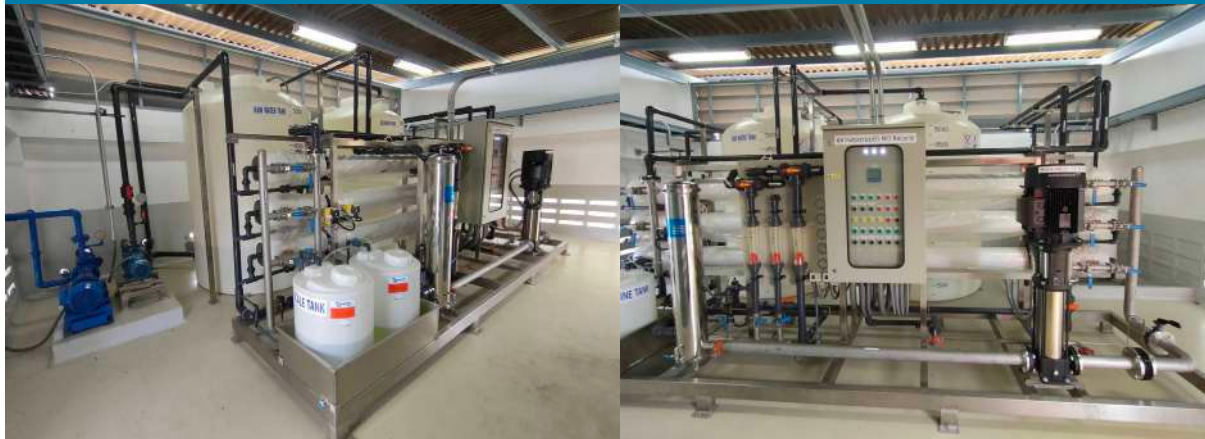
โครงการ RO recycle จากน้ำเสีย (บริษัท ไทยน้ำทิพย์ จำกัด โรงงานนครราชสีมา)
