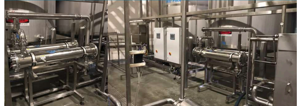
โครงการงานติดตั้ง UV Guard model X4-440 (บริษัท ไทยน้ำทิพย์ จำกัด โรงงานรังสิต-ปทุมธานี)
