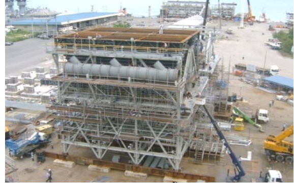
งานแปรรูปและประกอบกลุ่มชิ้นงานขนาดใหญ่ – อุตสาหกรรมเหมืองแร่โครงการ ALCAN GOVE ประเทศออสเตรเลีย
