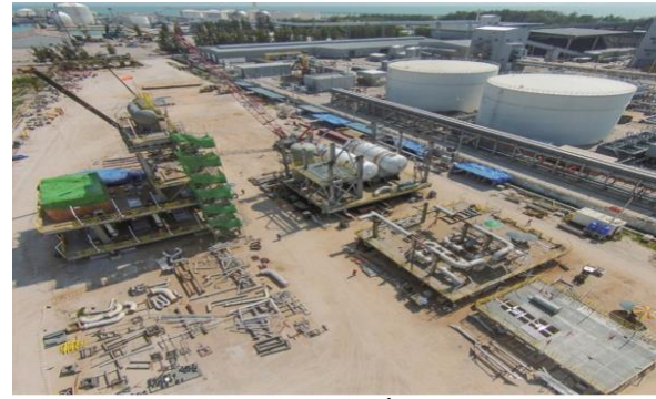
งานแปรรูปและประกอบกลุ่มชิ้นงานขนาดใหญ่ – อุตสาหกรรมน้ำมันและก๊าซโครงการ FPSOs P75/P77 ประเทศบราซิล
